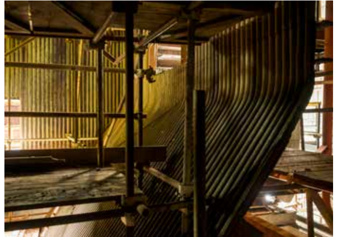
Vo výrezoch v bočných stenách kotla budú vo viacerých úrovniach umiestnené trysky na vstrekovanie močoviny do spaľovacej komory.
