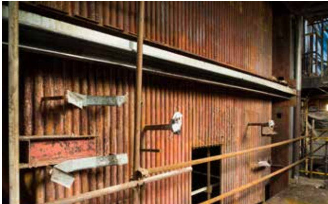
Vo výrezoch v bočných stenách kotla budú vo viacerých úrovniach umiestnené trysky na vstrekovanie močoviny do spaľovacej komory.
